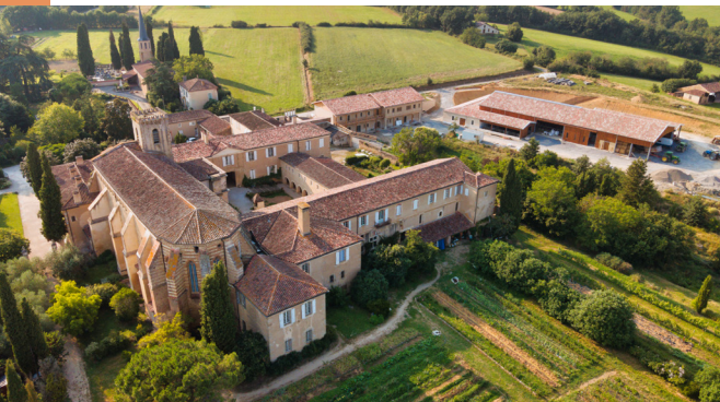
Rénovation de l'aile Est de l'Abbaye de Boulaur (32).
